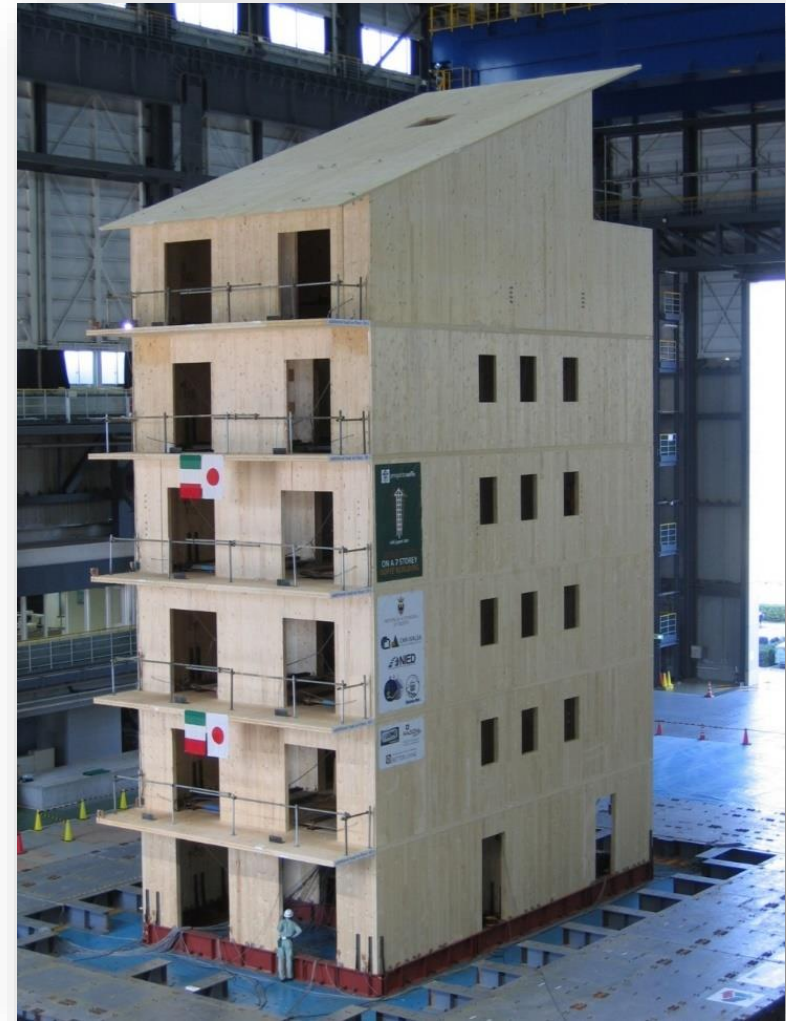
2007 – Test Miki (Giappone) su un edificio in legno di 7 piani
