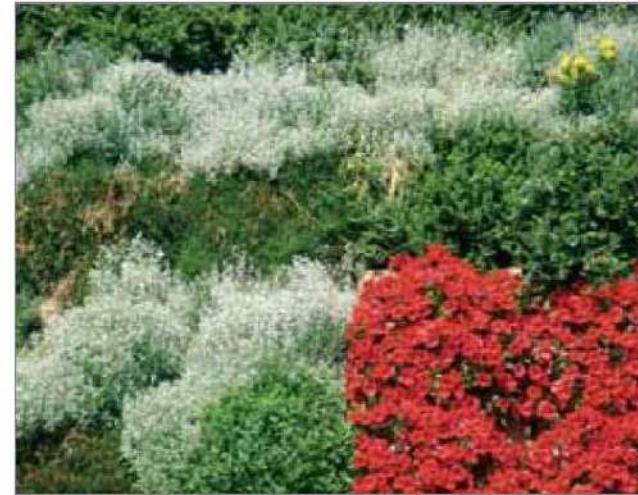
Pareti Verticali su Parete Fonoassorbente, Cartiera Collodi, Pescia (impianto 2010)
