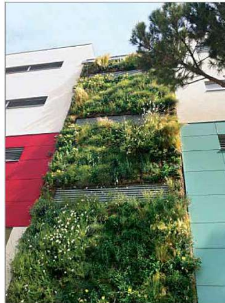
Pareti Verticali, Palazzo Condominio Casa Gaia, Rimini (impianto 2014)
