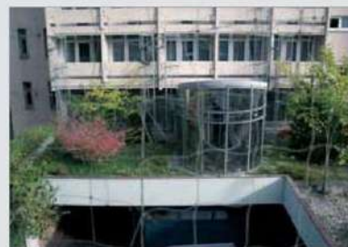
Fig. 3.24 - Il verde pensile, ampiamente diffuso a copertura di tetti e solai (in foto, esempio di giardino pensile trattato come verde intensivo complesso per via della presenza di esemplari arborei).
