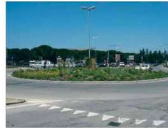
Rotonde ecologiche (steppa con letto d'impianto a compost organico).
