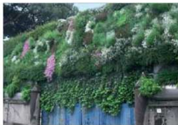
Giardino verticale con inserto basale di verde parietale a rampicanti e fioriera.
