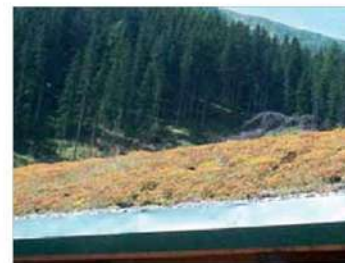
Tetto verde estensivo a mix di sedum.
