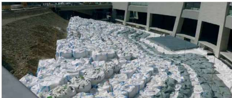
Posa di sacconi di IGROPERLITE® su copertura inclinata.
