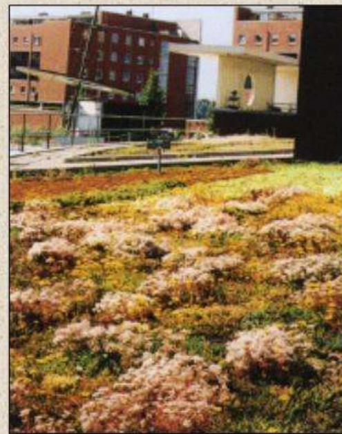
Palazzina Uffici, Amsterdam, Olanda
