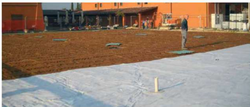
Stesura di telo di filtrazione DRENALI™F sopra a materassini GROWMAT™.
