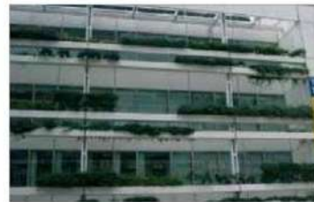
Facciata con verde parietale discontinuo.
