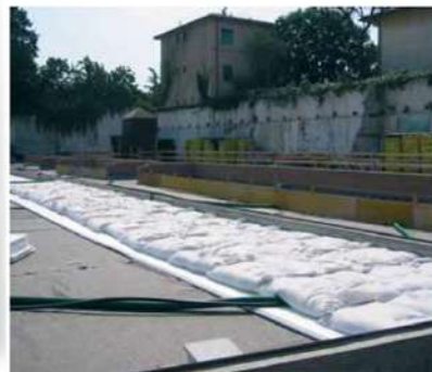
Posa di sacchi di IGROPERLITE® su lastre di SUPERGARDEN®.
