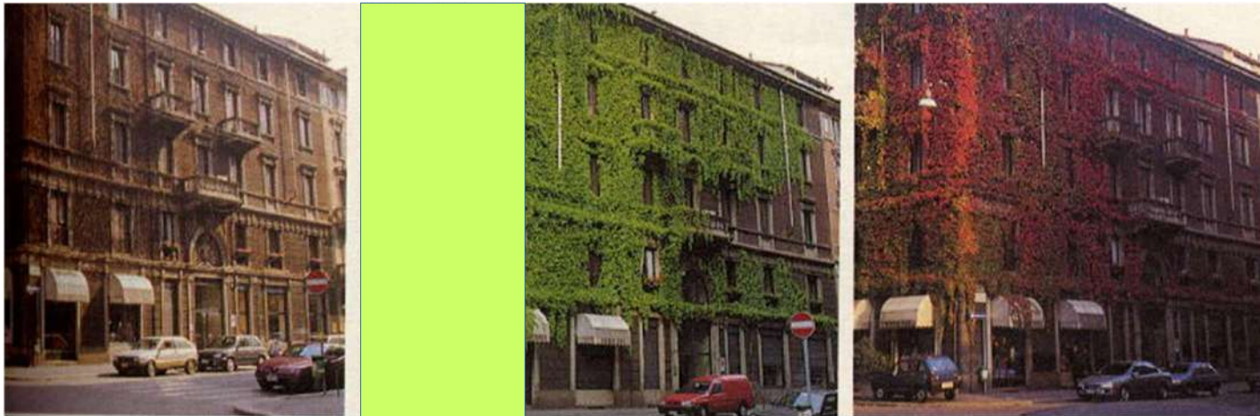
Casa d'abitazione (inizi novecento) in via Leopardi a Milano nei diversi assetti stagionali
