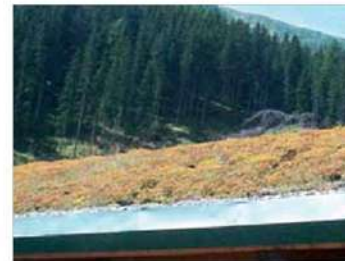
Tetto verde estensivo a mix di sedum.
