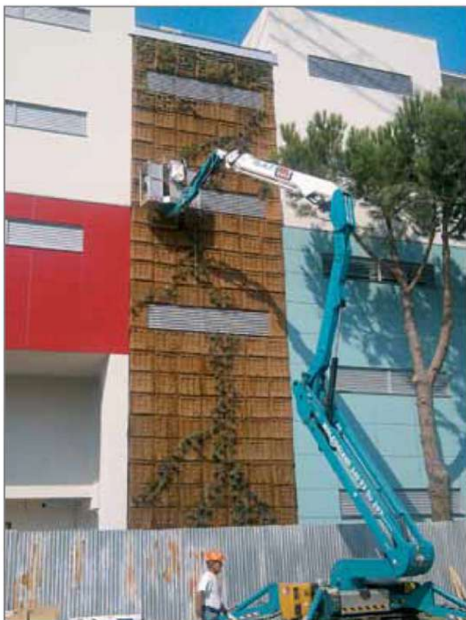
Fig. 6.7 - Fasi della realizzazione di un giardino verticale sulla facciata sud di un edificio ad alta efficienza energetica (Rimini, Casa Gaia, 2011; Mengoli, progetto paesaggistico "Paesaggio fluviale").
