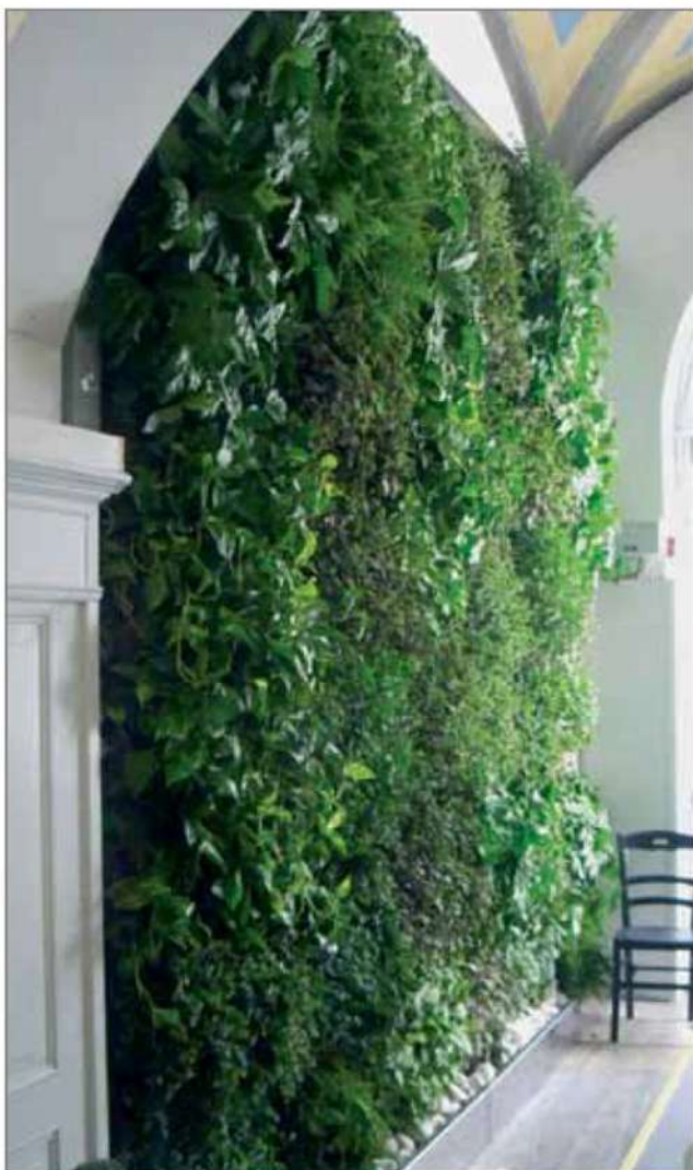
Fig. 7.12 - Muro vegetale indoor (Prato), con illuminazione naturale. La Composizione varietale è Ficus repens e F. repens white , Ficus elastica , Hypoestes phillostachya Rosa, Fittonia albivenis , Nephrolepis exaltata , Fatsia japonica . La Tipologia compositiva è basata su un tema naturalistico.
